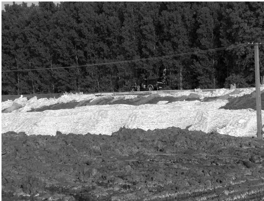
1. kép. Árvédelmi töltés 6 m-es rézsűcsuszása Szelevény mellett a 2006-os tavaszi árvízkor
