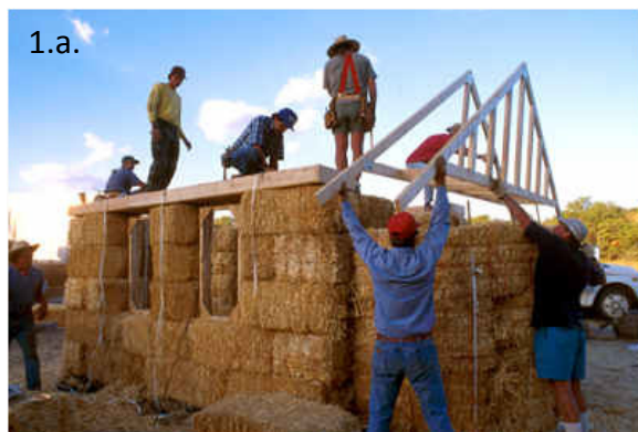
1.a. ábra. Teherhordó típusú szalmaház építés közben
